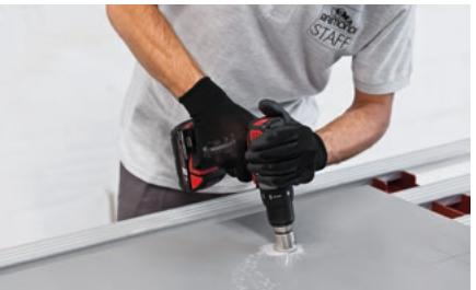
Per la realizzazione di fori si raccomanda l'uso di fresa diamantata avendo cura di bagnare costantemente la superficie.
