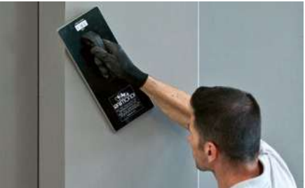
Posata la lastra, batterla o vibrarla dal centro verso l'esterno, parallelo lato corto, per compattare l'adesivo espellendo l'aria.
