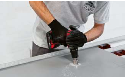
Per la realizzazione di fori si raccomanda l'uso di frese diamantate avendo cura di bagnare costantemente la superficie.
