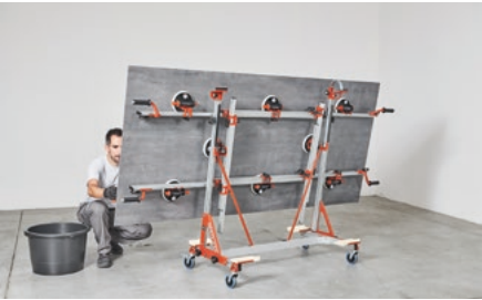
L'obiettivo da perseguire è lo strato compatto di adesivo, senza vuoti d'aria. Stendere l'adesivo con la tecnica della doppia spalmatura. L'adesivo deve essere spalmato, con idonee spatole, sempre parallelo al lato corto sia sulla lastra con spatola minimo dente 3x3, che sul fondo su cui va applicata con spatola minimo dente 10x10.
