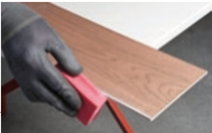
FR Effectuer la finition des bords à vit avec une cale à poncer ou des disques diamants. DE Die geschnittenen Kanten dann mit Schleifpads oder Diamantschleifscheiben nachbearbeiten.
