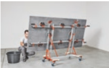
L'obiettivo da perseguire è lo strato compatto di adesivo, senza vuoti d'aria. Stendere l'adesivo con la tecnica della doppia spatolata. L'adesivo deve essere spalmato, con idonee spatole, sempre parallelo al lato corto sia sulla lastra con spatola minimo dente 3x3, che sul fondo su cui va applicata con spatola minimo dente 10x10.
