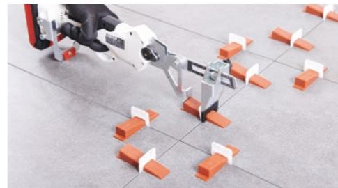
Utilizzare sistemi di livellatura per assicurare una installazione appropriata e rendere perfetta la planarità della superficie posata.
