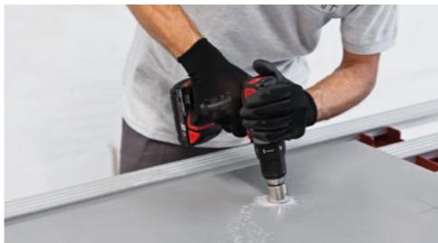
Per la realizzazione di fori si raccomanda l'uso di fresa diamantata avendo cura di bagnare costantemente la superficie.
